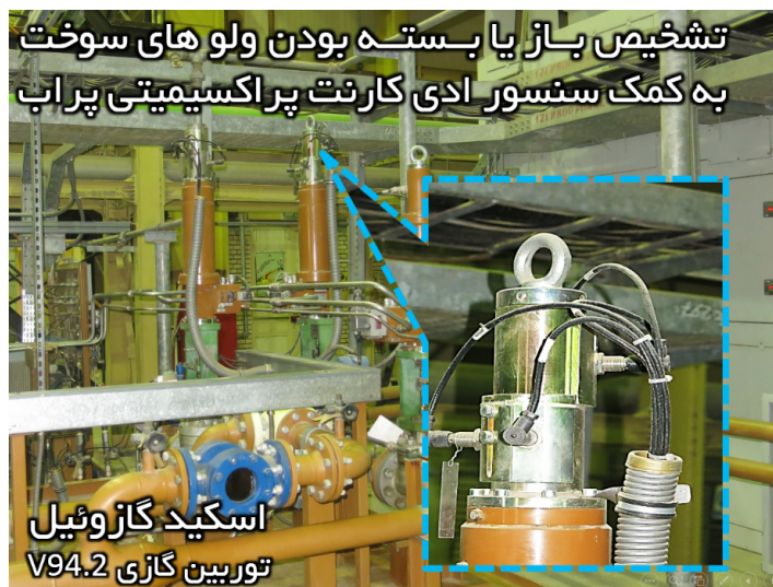
شکل ۴-۸ سنسور ادی کارنت پراکسیمیتی پراب در نقش میکروسوئیچ
