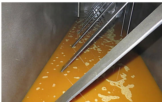
تصویر (۷-۱۰) - شستشوی شیمیایی تانک روغن توربین گازی MGT70 مپنا
